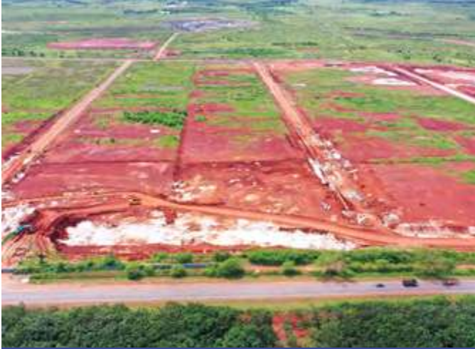
Pakej 1: Kerja-kerja Tanah Bagi Penyediaan Plot Industri
