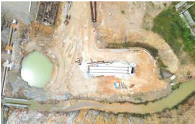
Pakej 1: Kerja-kerja Tanah di KRC
