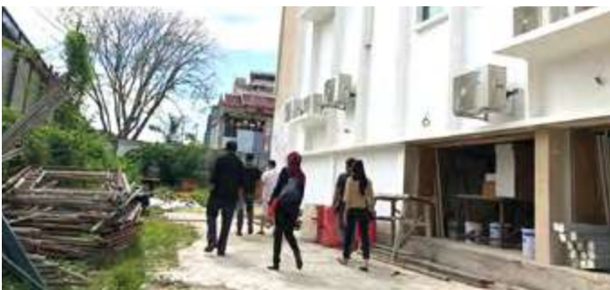
Lawatan tapak ke Frazel Heritage Hotel yang terletak di Alor Setar, Kedah. Hotel ini dijangka akan siap sepenuhnya pada Disember 2022
