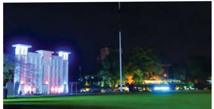
Pakej 1A: Pembinaan dinding fasad untuk pertunjukan cahaya dan bunyi di Ipoh Padang
