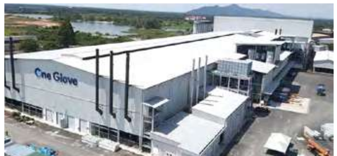
Kilang Onetexx Sdn Bhd yang terletak di Kawasan Perindustrian Kamunting Raya, Perak telah siap sepenuhnya dan memulakan operasi pada Oktober 2021
