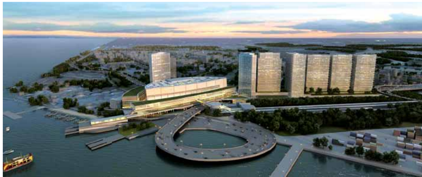
Pembangunan Penang Sentral
